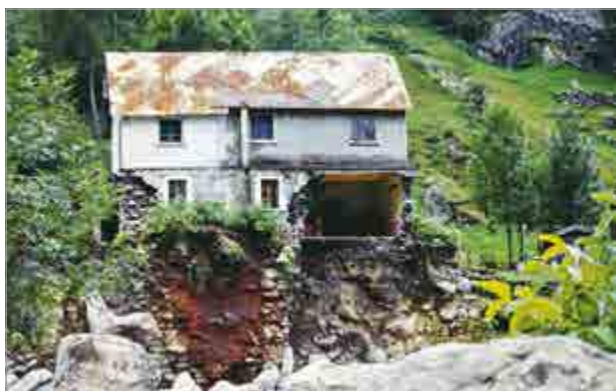
fig. 5 – La Privativa Tavelli (Vedello) lesionata dall'esonazione del torrente Caronno (17-18 luglio 1987). Sotto la struttura sono visibili i probabili resti del forno fusorio ottocentesco poi inglobati nella ricostruzione del nuovo argine (© Marino Amonini).
