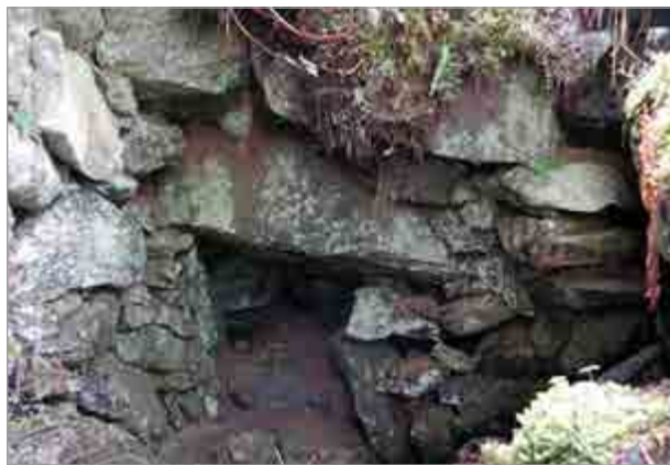
fig. 1 – Località Li gèeri (Piaveda), particolare dell’apertura basale per lo scarico del minerale (© Ilaria Sanmartino).
