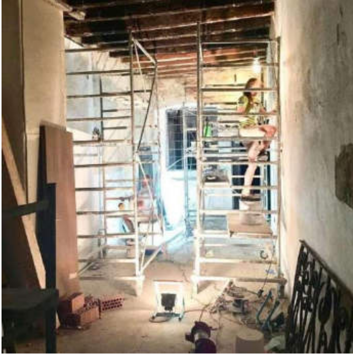
Taf. 24a Bozner Laubenhaus 62 während der Renovierungsarbeiten, 2018
