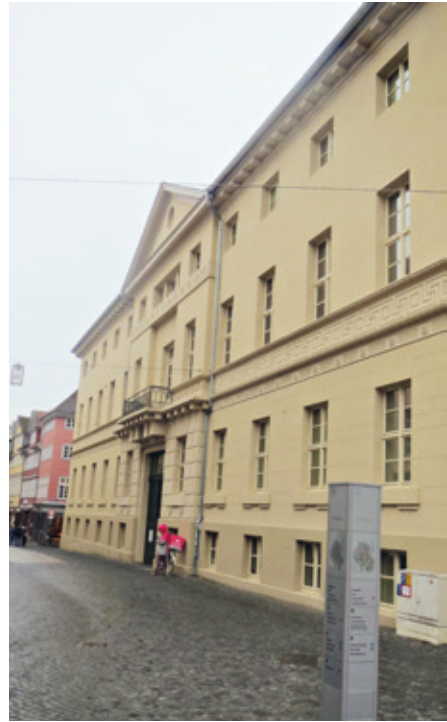
Abb. 4 Braunschweig, Vieweghaus, Südseite.
