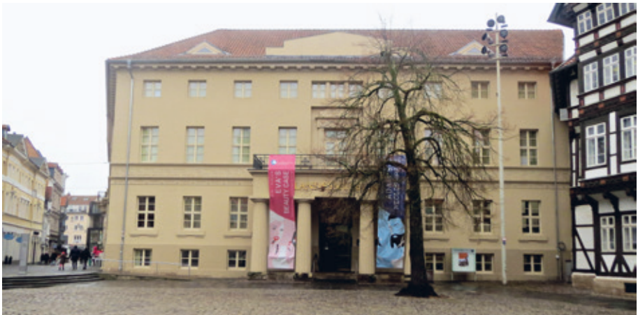
Abb. 2 Braunschweig, Vieweghaus, Ostseite.
