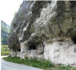
Fort Civezzano Recovery
