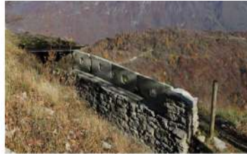
Trenches Kolovrat, Slovenia
