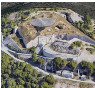
Mont-Chauve d'Aspremont Fort New use - support civil aviation
