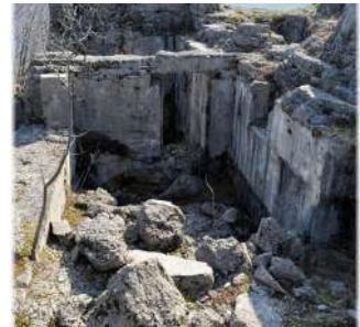
Batteria Tombio State of abandonment
