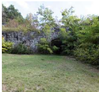
Batteria Brusaferrò State of abandonment
