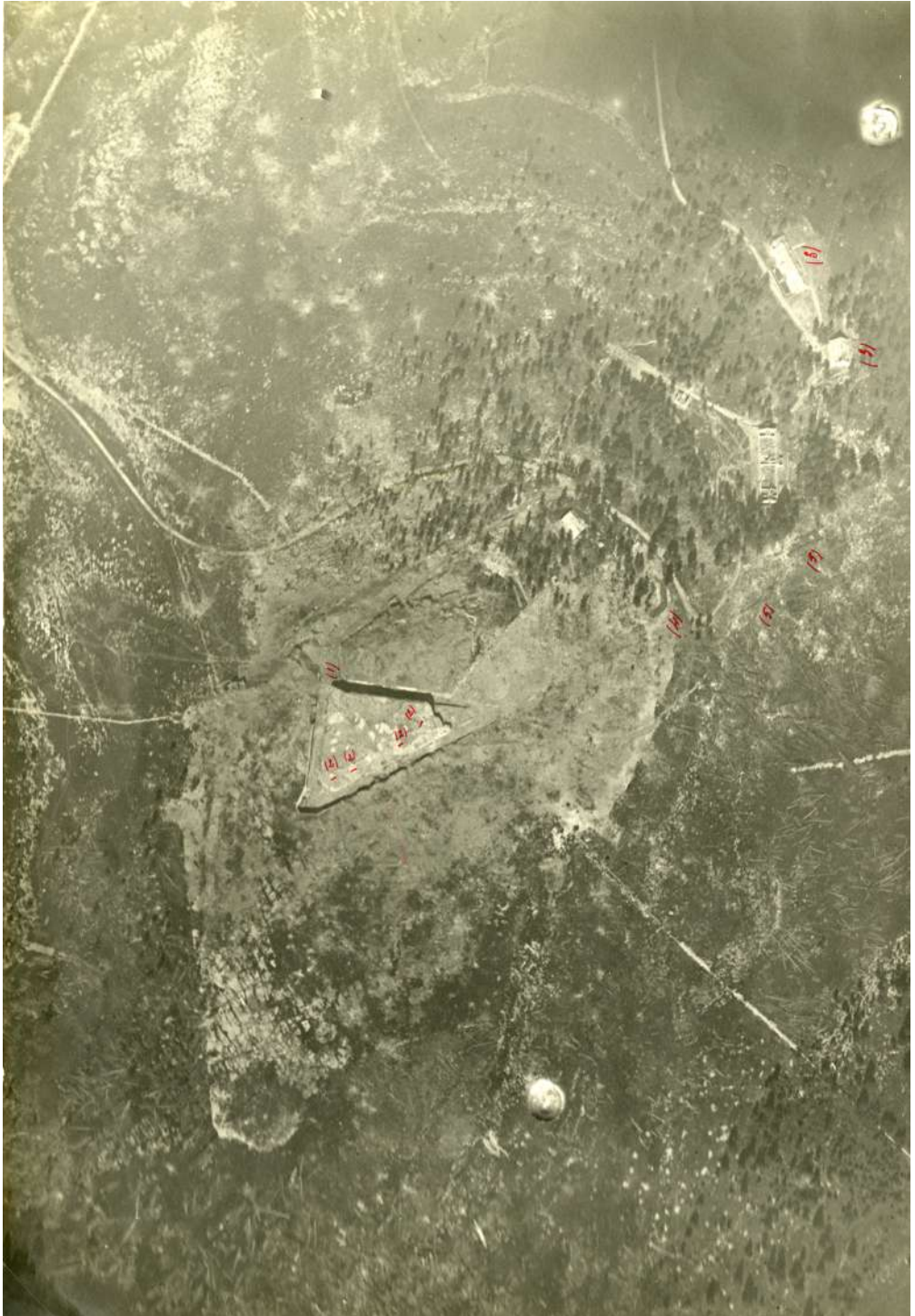
Period aerial photography, area around Campo Luserna Fort, wartime. Museo Storico Italiano della Guerra, Rovereto (TN), Italy
