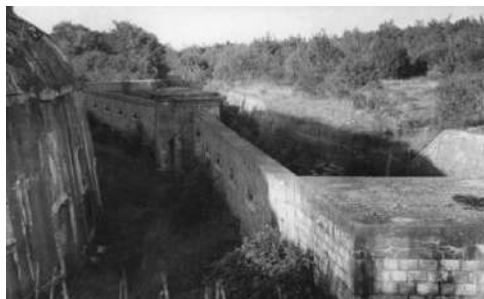
Fort de Trondes Wartime
