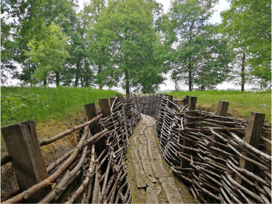
Pic.7.8 Bayerwald Trenches, nei pressi di Ypres. Graticci in legno per contenimento terreno e assi lignee per pavimentazione.
