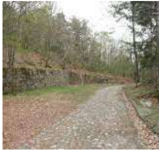
Batteria Casara State of abandonment
