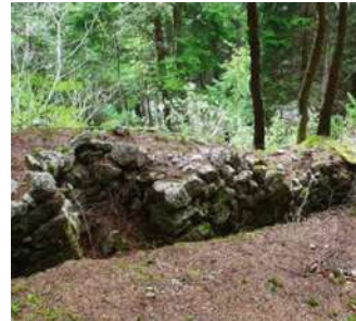
Batteria Mandolin State of abandonment
