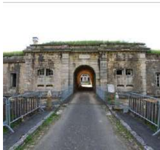
Fort de Bressencour Recovery
