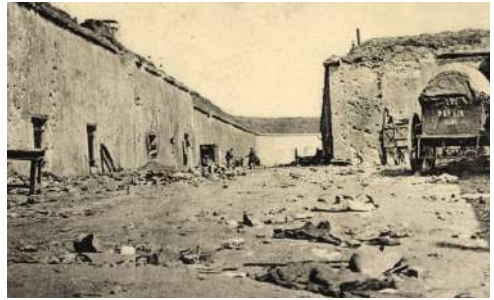
Fort de Fleron- Liegi Wartime
