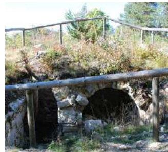
Batteria Maranza State of abandonment
