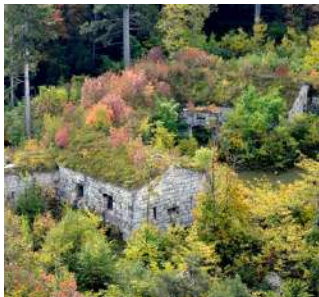
Batteria Doss Fornas State of abandonment
