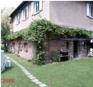
Fort von der Tann High level of transformation
