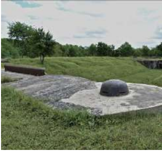
Fort du Vieux-Canton Recovery
