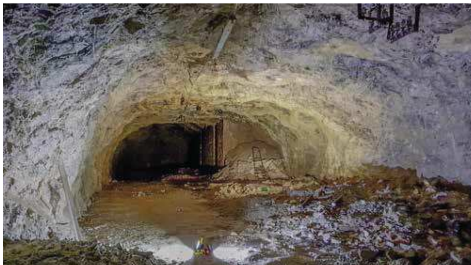
Fig. 1 - Vista interna dello stato attuale del rifugio Alla Busa di via Grazioli.
