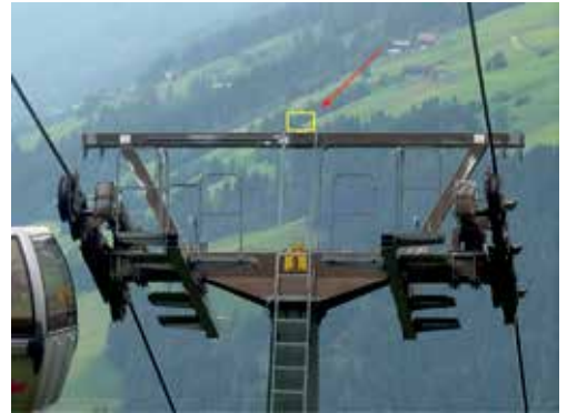
Figura 17: punto di possibile appoggio della fune di segnalazione sul "falco" del sostegno (quadrato giallo indicato dalla freccia).
