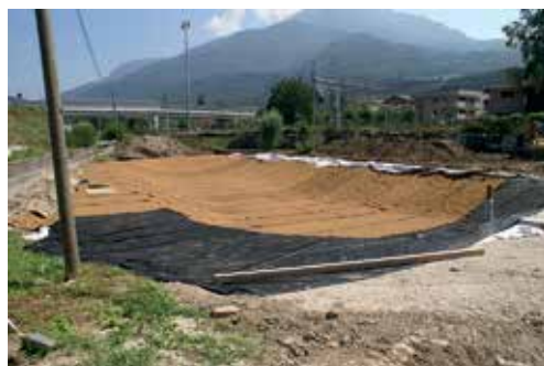
Fig. 2 Impermeabilizzazione del laghetto
