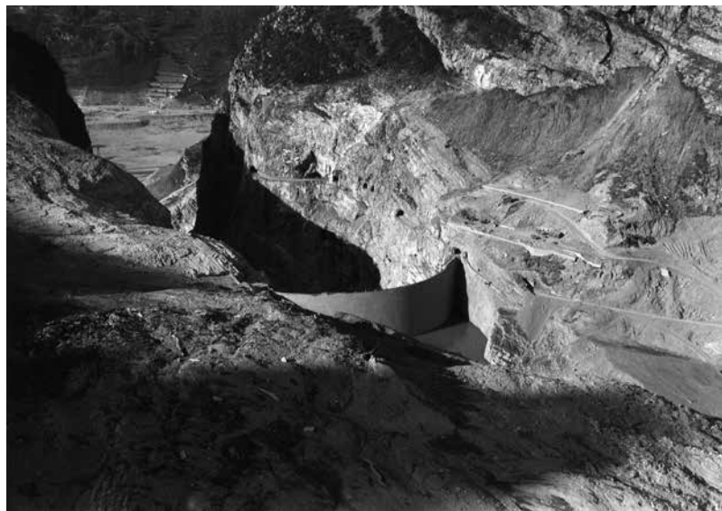
Figura 3. La diga del Vajont con le “ferite” provocate dalla frana sui lati della valle del Vajont e la distruzione del paese di Longarone nella sottostante valle del fiume Piave (ACS, M.I.G. 1967-1970, busta 232, fascicolo. 14519/11/1/9-10, sottofascicolo 10; concessione 1264/2015, prot. 792, class. 43.10-00, 17.2.2015).
