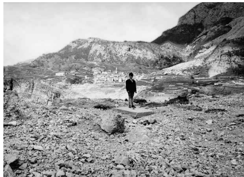
Figura 5. Un bambino fotografato sulla frana del Vajont, sullo sfondo la frazione di Casso soprastante la diga di quasi 250 metri e lambita dall'onda d'acqua sollevata dalla caduta della frana nel bacino idroelettrico, 25 aprile 1964 (ASAq-ASBI, APV, busta 20, fascicolo 1; concessione 1/2015, prot. 398, 10.2.2015).
