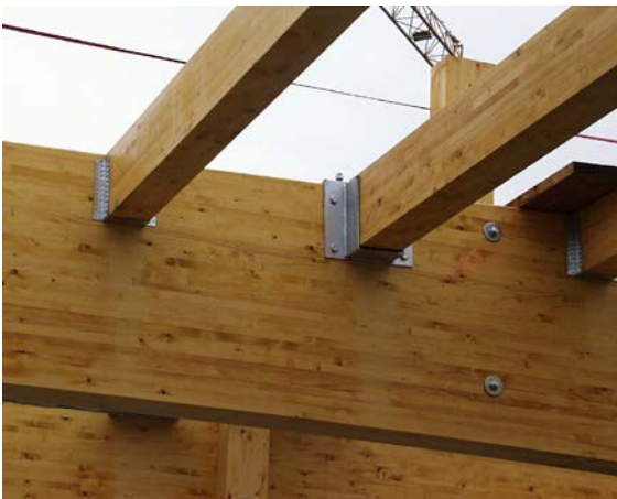
Figur 16.16 Anslutningar som kan behöva brandskyddas med hjälp av obrännbar skiva.
