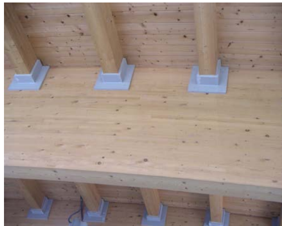
Figur 16.16 Anslutningar som kan behöva brandskyddas med hjälp av obrännbar skiva.
