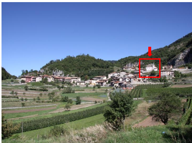
Fig. 3.35 Chiesa di San Antonio Abate, Manzano
