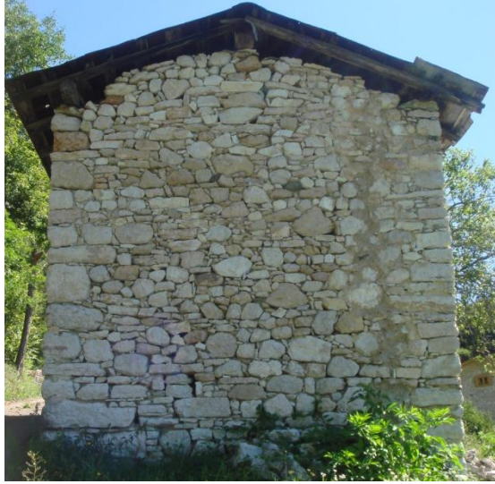
Fig. 5.14 Immagine muratura perimetrale a Corniano
