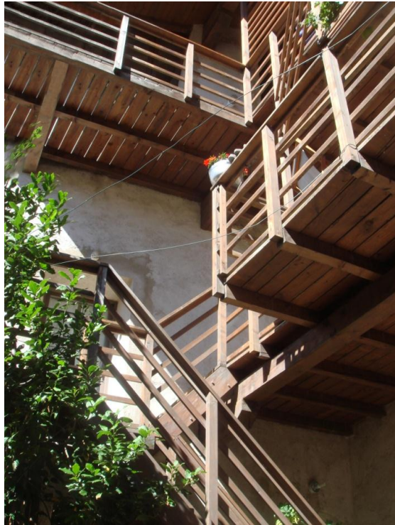
Fig. 5.29 Ballatoi casa a Nomesino
