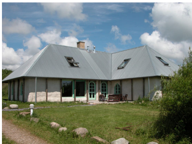
Figura 6.37: Edificio moderno in balle di fieno, www.ecobrooklyn.com .
