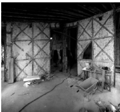
Figura 2.1: Costruzione pombalina del XVIII secolo, Langenbach (2006).
