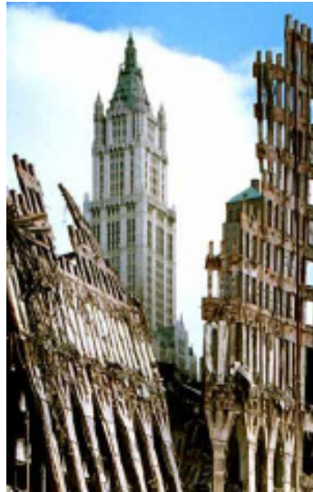
Figura 2.14: Grattaciolo Woolworth, NY, realizzato con la tecnica Chicago Frame, Langenbach (2003).
