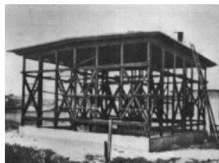
Figura 2.3: Costruzione a telaio ligneo nella fase postsismica del 1908, Barbisan (1997).
