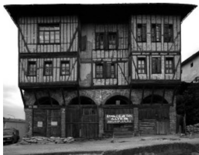
Figura 2.4: Costruzione tipica turca-ottomana, Langenbach (2006).
