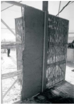
Figura 2.12: Realizzazione costruzione con tecnica quincha, Gálligo (2005).
