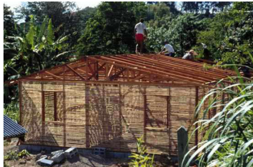
Figura 2.13: Edificio prefabbricato in bamboo bahareque, Gutierrez (2004).
