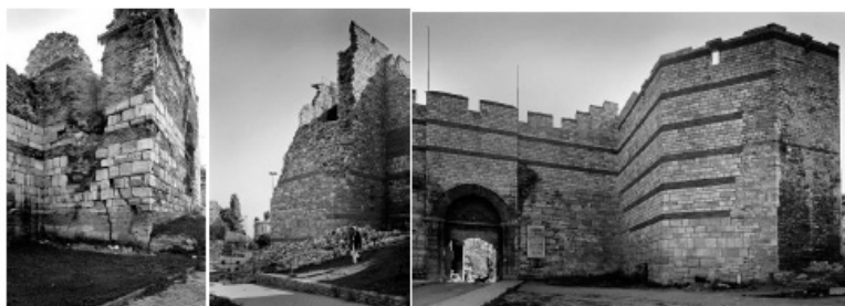
Figura 2.5: Mura di Istanbul dopo il terremoto del 1999; la porzione antica resiste (sx), crolla la porzione restaurata di recente, Langenbach (2006).
