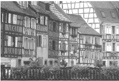
Figura 2.7: Tecnica fachwerk, presso Mulhouse (Francia), Ceccotti e altri (2007).
