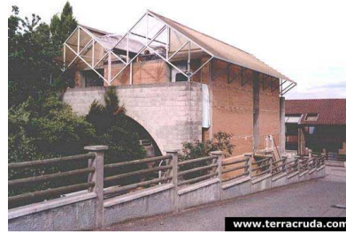
Figura 2.108: Costruzione in pisé, Villefontaine, www.terracruda.com .
