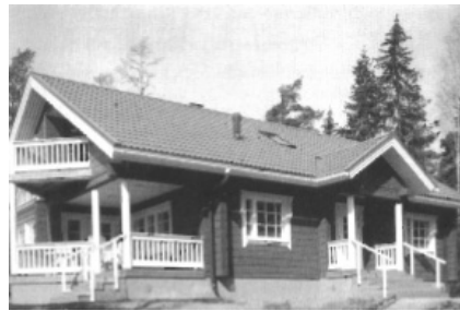
Figura 2.8: Costruzione a tronchi massicci, (Finlandia), Ceccotti e altri (2007).
