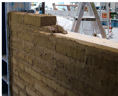
Figura 4.9: Particolare inserimento partizione in legno nella struttura.
