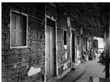
Figura 2.11: Costruzione taquezal dopo il terremoto del 1986 in San Salvador, Langenbach (2006).
