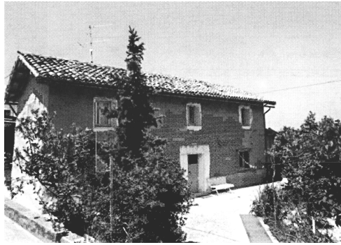
Figura 2.103: Costruzione abitata in massone, Perrotti e Pisano (1999).
