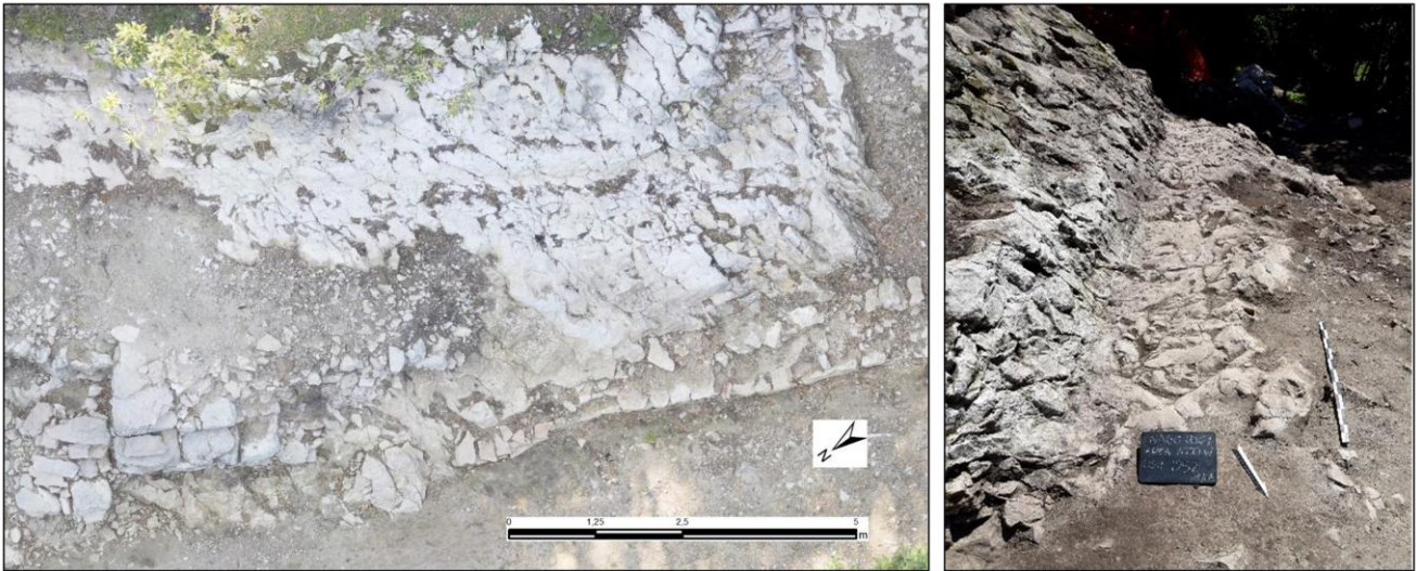
Fig. 17. Il probabile tracciato stradale rinvenuto sul Doss Penede, con evidenza del taglio realizzato sulla roccia a monte e della substructio di contenimento costruita a valle.
