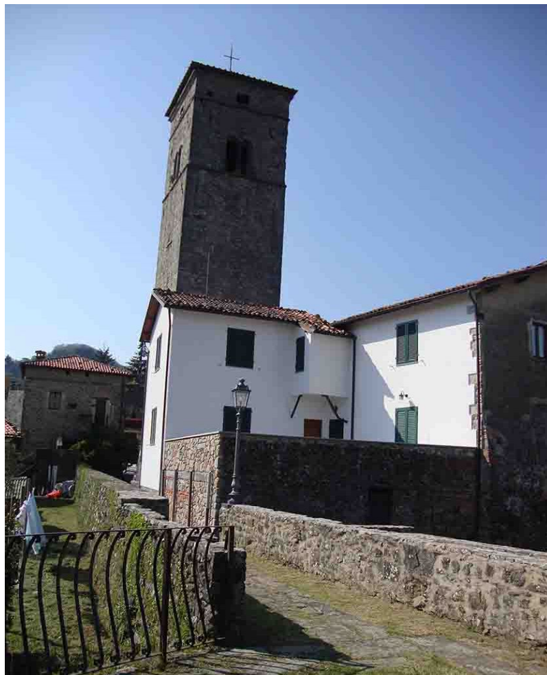
La canonica di Cascio dopo il restauro (2009).
