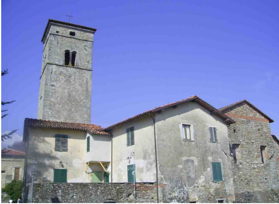
La canonica di Cascio prima del restauro.
