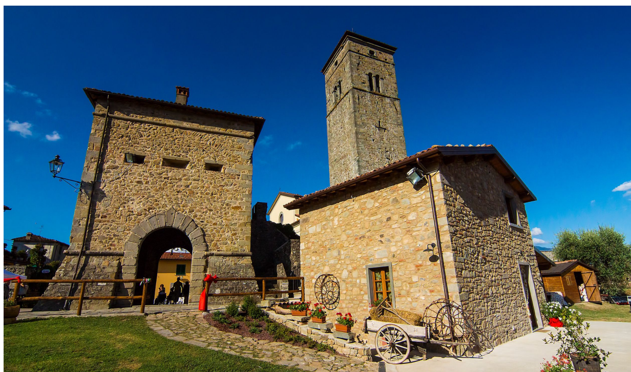
L'ex stalla parrocchiale ristrutturata e convertita in edificio ad uso sociale e ricreativo (2013).
