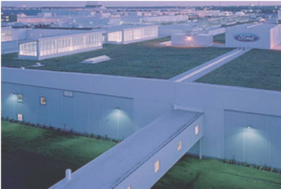
I tetti verdi mitigano il troppopieno delle acque meteoriche Green roofs reduce stormwater runoff and moderate climate
