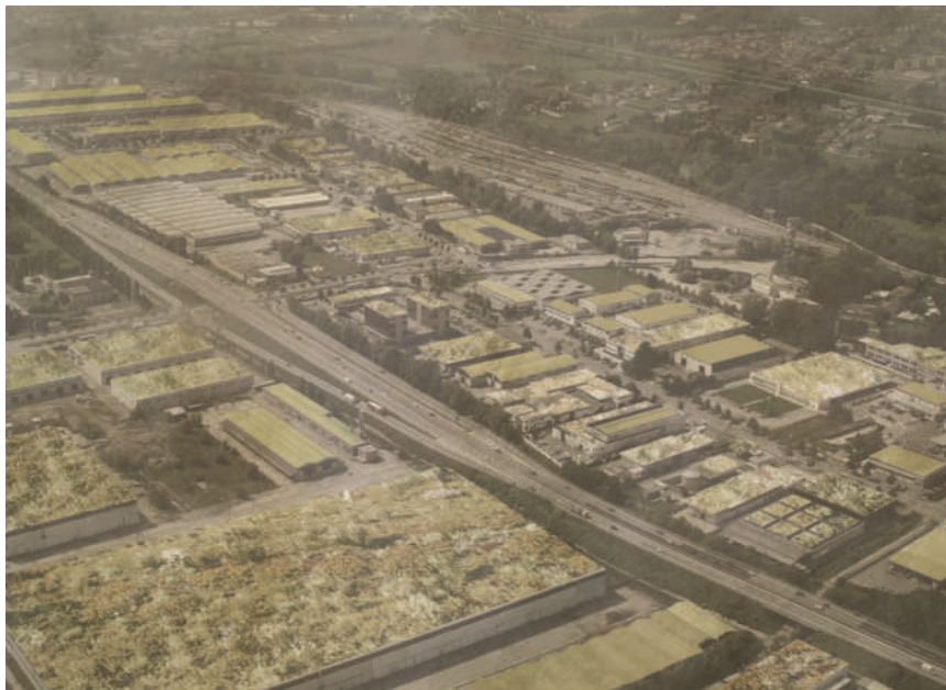
Possibile utilizzo delle coperture della ZIP ZIP aerial view of potential new roof uses
