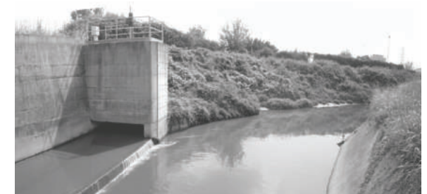
Punto in cui il Canale Fossetta confluisce allo scoperto nel Canale Roncajette Fossetta River emerges from a pipe beneath North ZIP and flows into public space
