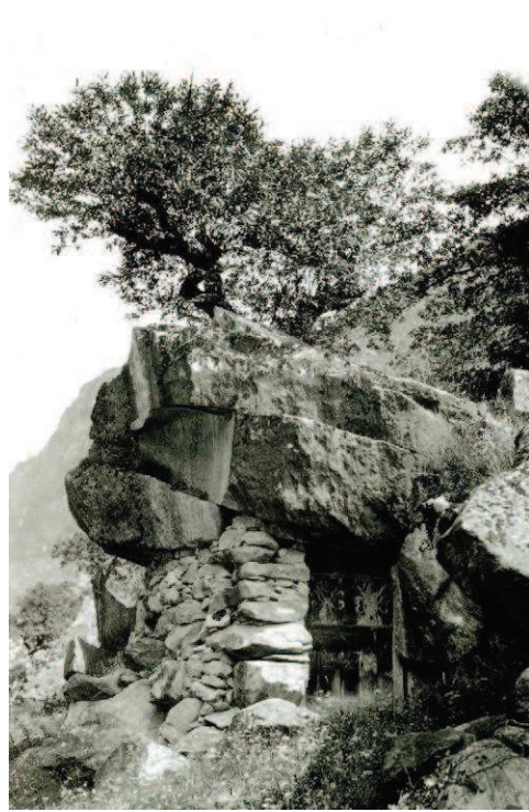
Fig. 9: un'area di stoccaggio ricavata strutturando un riparo sottoroccia (da Scheuermeier 2007: 114)
