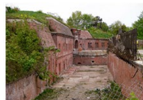
12. Fort IX - Thorn/Torun (Polonia) Stato di abbandono
