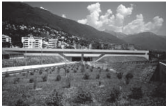
Aurelio Galfetti Rotonda di Piazza Castello Locarno, Svizzera
