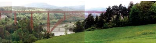
Latitude Nord Aire de repos autoroutière à Garabit. project 1995 - 1999 realization 2001...in progress France.
