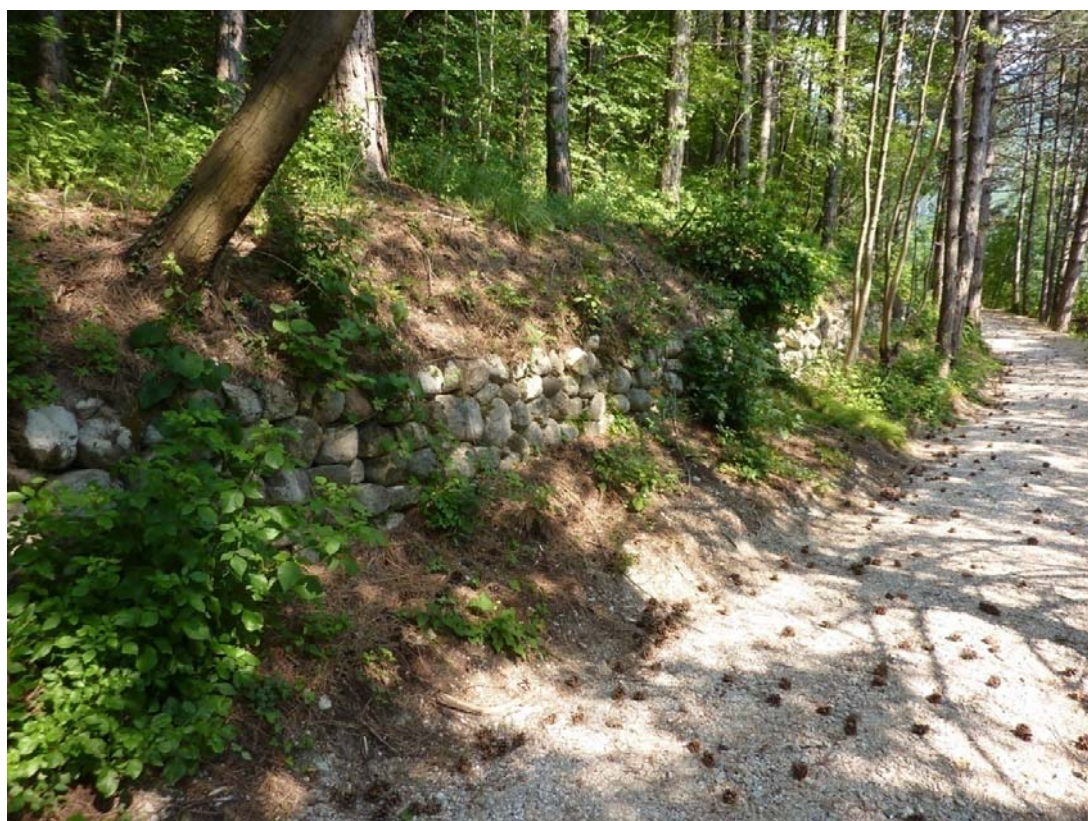
Figg. 8-11 – Esempi di sistemi terrazzati in abbandono. Foto di T. Gilardi e A. Tanzarella
