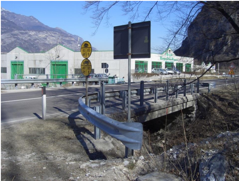
Fig. 67: Rio Secco bridge ( www.bms.provincia.tn.it )
