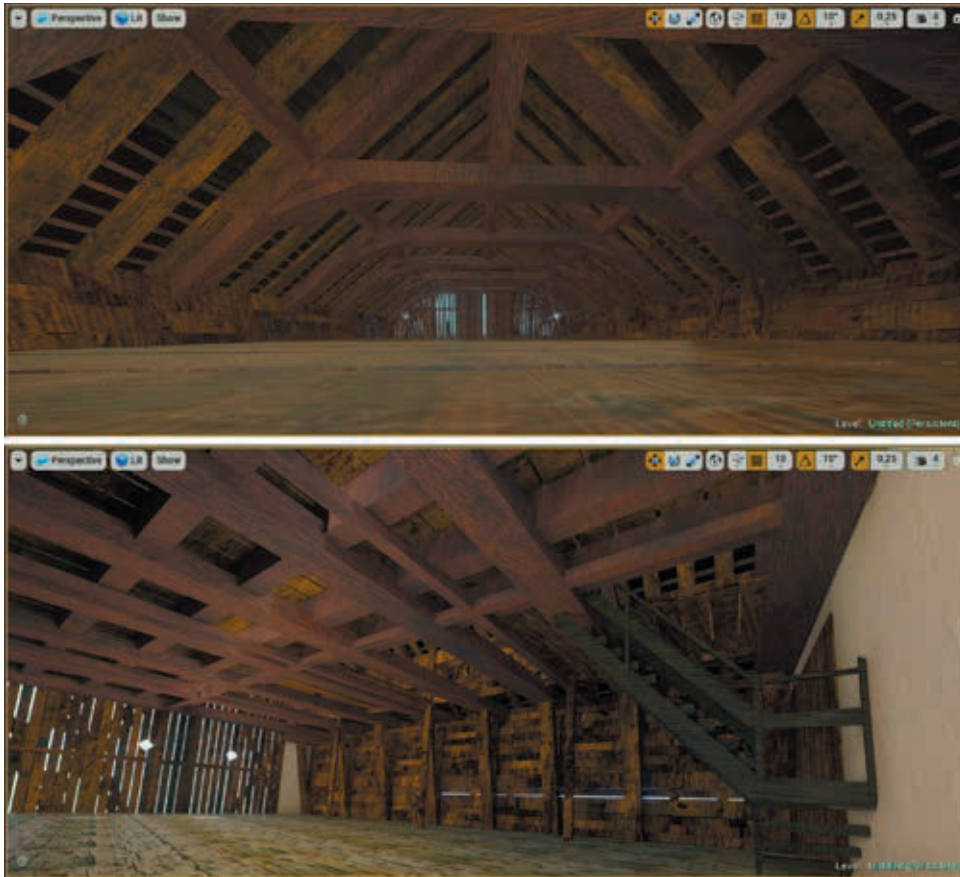
Fig.7 Viste interne. Complesso sistema capriata in esplorazione RTR.
