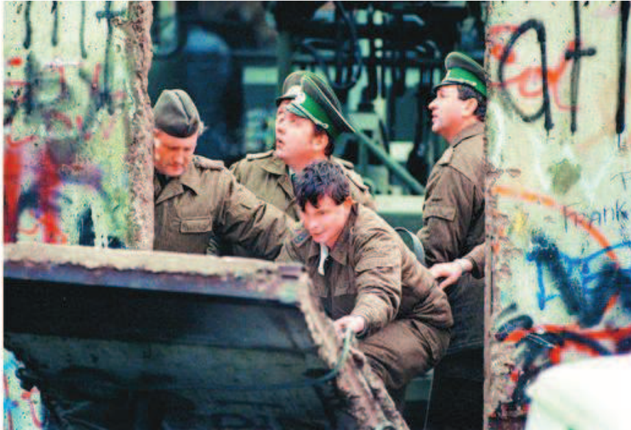
Grenztruppen alle prese con i lavori di demolizione ufficiale del Muro.
