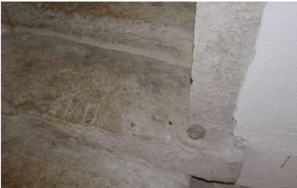
Abb. 33 Rovereto, Via della Terra, Centro socio-educativo Terra, Spur der ehem. Türangel
