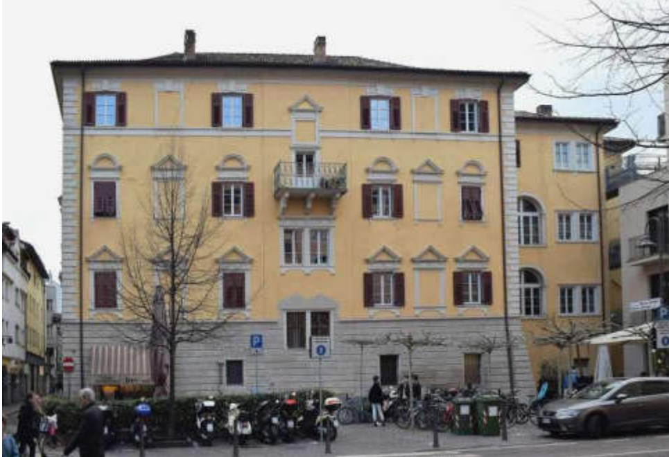
Abb. 137 Bozen, Schrofenstein, Ansicht von Osten
