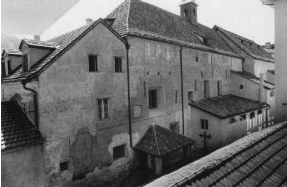
Abb. 46 Bozen, Nordmauer des Kapuzinerkloster mit Spuren des mittelalterlichen Bestandes der ehem. Burg Wendelstein
