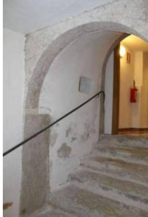
Abb. 32 Rovereto, Via della Terra, Centro socio-educativo Terra, Toreinrahmung
