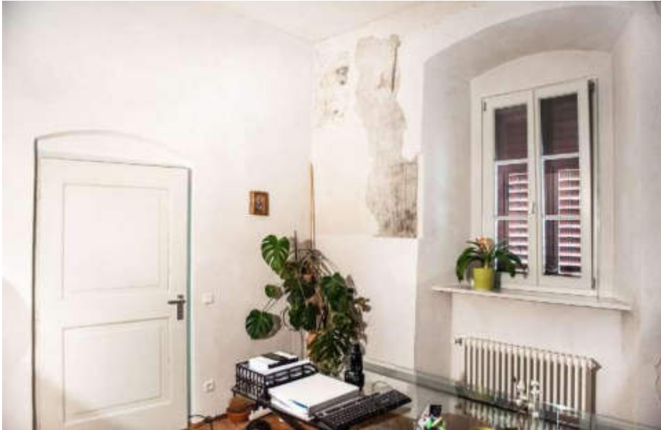
Abb. 146 Bozen, Schrofenstein, südöstlicher Raum, Nordwestecke
