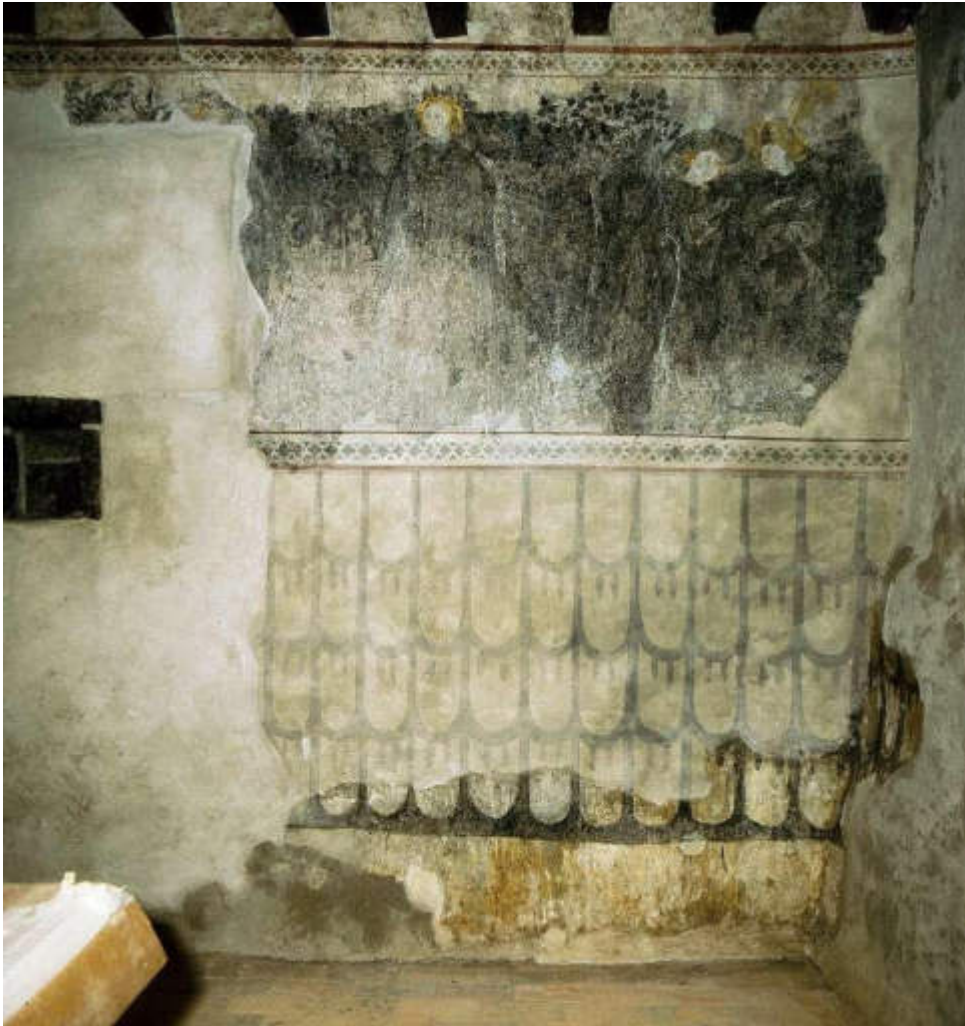
Abb. 188 Oberau-Haslach (Bozen), Ansitz Niederhaus-Thun, Raum im Erdgeschoss, Nordostecke
