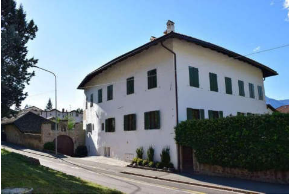
Abb. 181 Oberau-Haslach (Bozen), Ansitz Niederhaus-Thun, Ansicht von Norden
