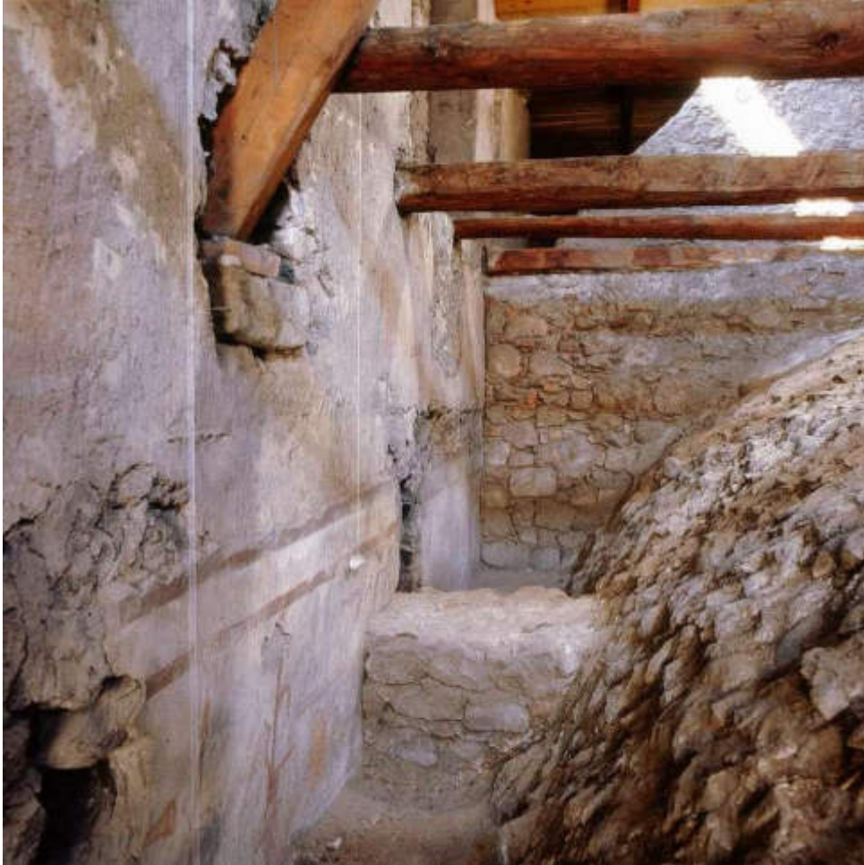
Abb. 51 Bozen, ehem. Burg Wendelstein, Südwand vor dem Abbruch des Tonnengewölbes
