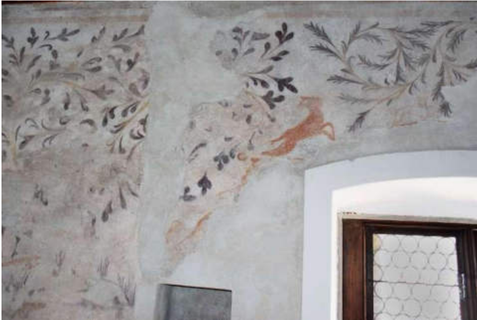
Abb. 103 Runkelstein, Ostbau, südlicher Raum im ersten Obergeschoss, Westwand
