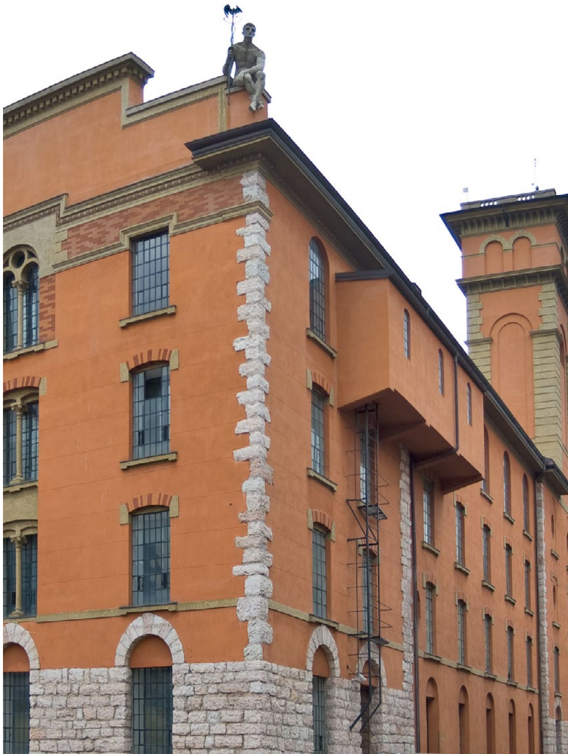
Facciata verso il cortile interno, Archivio UniTrento, ©Paolo Chistè 2009
