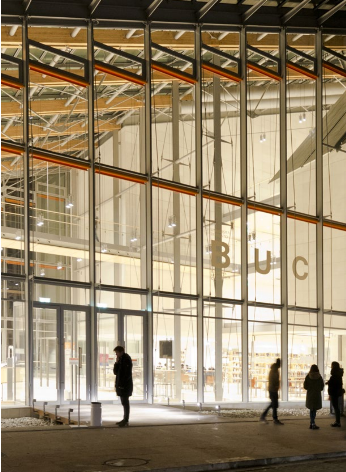
Facciata, Archivio UniTrento, ©Umberto Botti 2016
