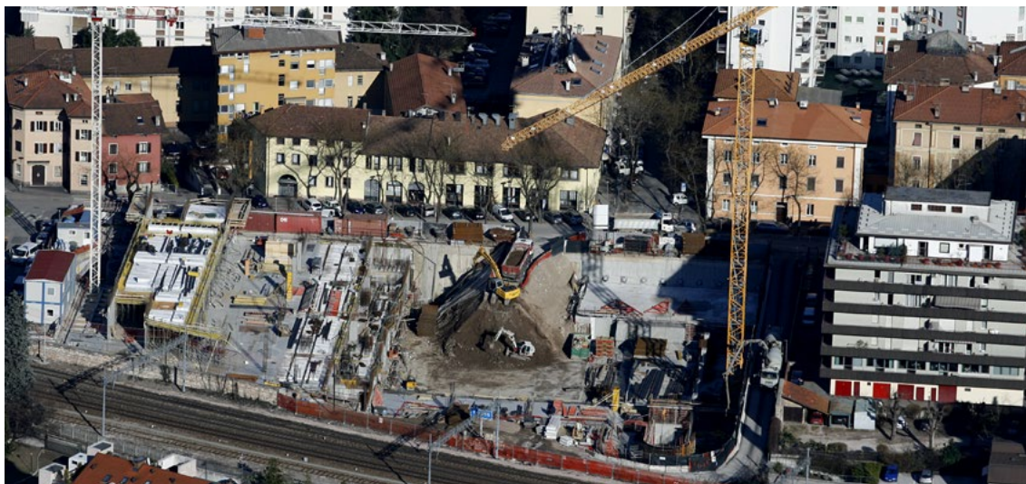
Il cantiere del Dipartimento di Lettere, Archivio UniTrento, ©Mattia Zomer 2010
