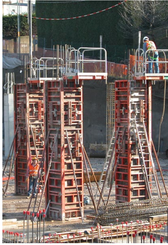
Cantiere del Polo Ferrari, Povo di Trento, Archivio UniTrento, ©Mattia Zomer 2008
