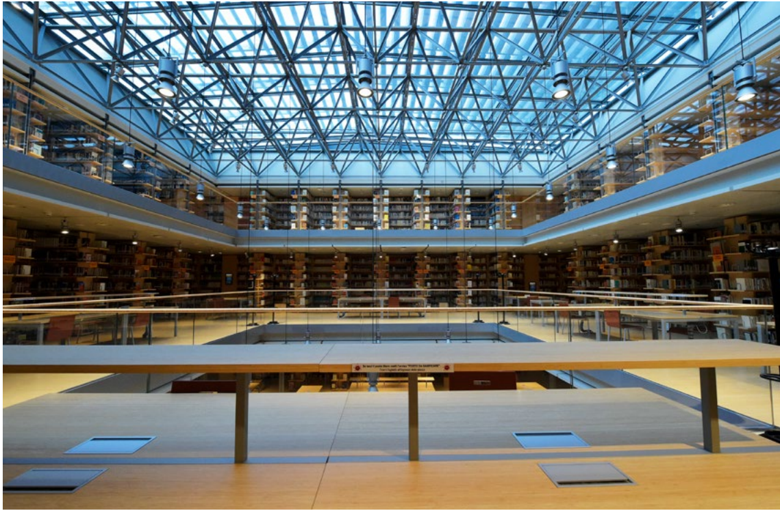
Sala studio - Struttura della copertura in acciaio, Archivio UniTrento, ©Alessio Coser 2020
