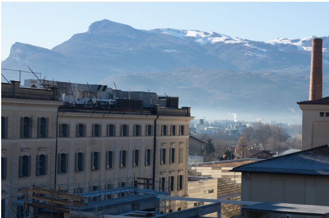
Cantiere per la sede del CIMEC, Archivio UniTrento, ©Michela Favero 2023
