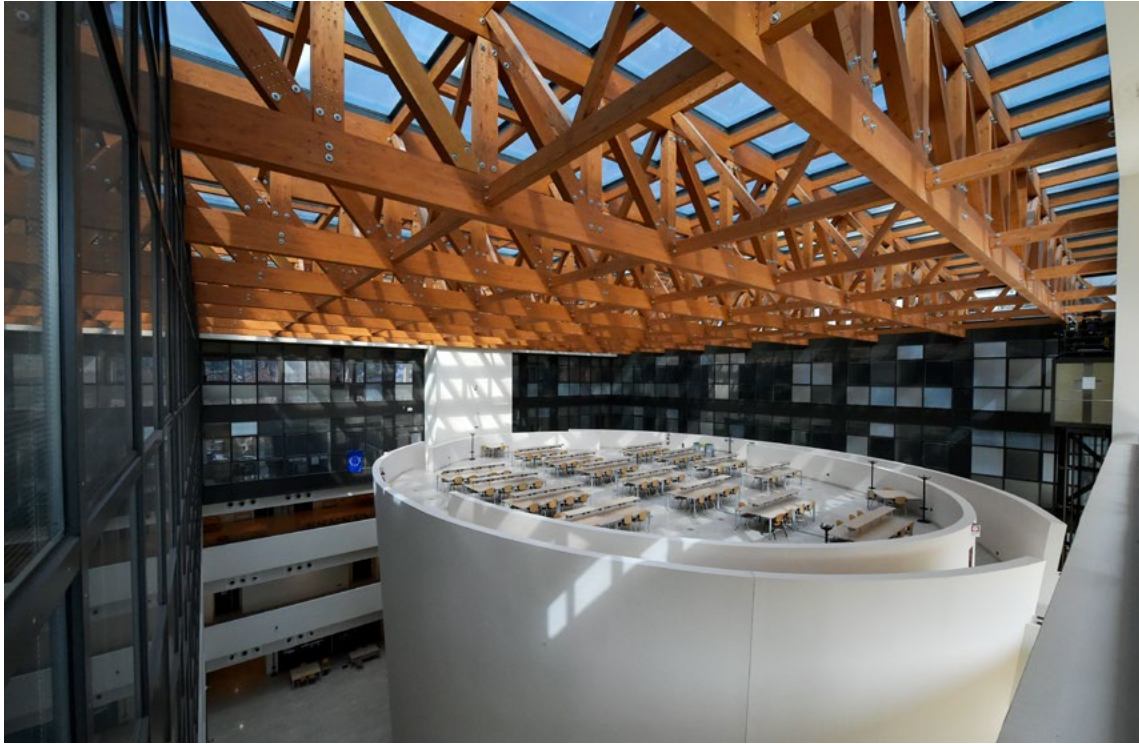
Il volume dell'aula magna con la sala studio sovrastante e la struttura in legno della copertura, Archivio UniTrento, ©Alessio Coser 2020
