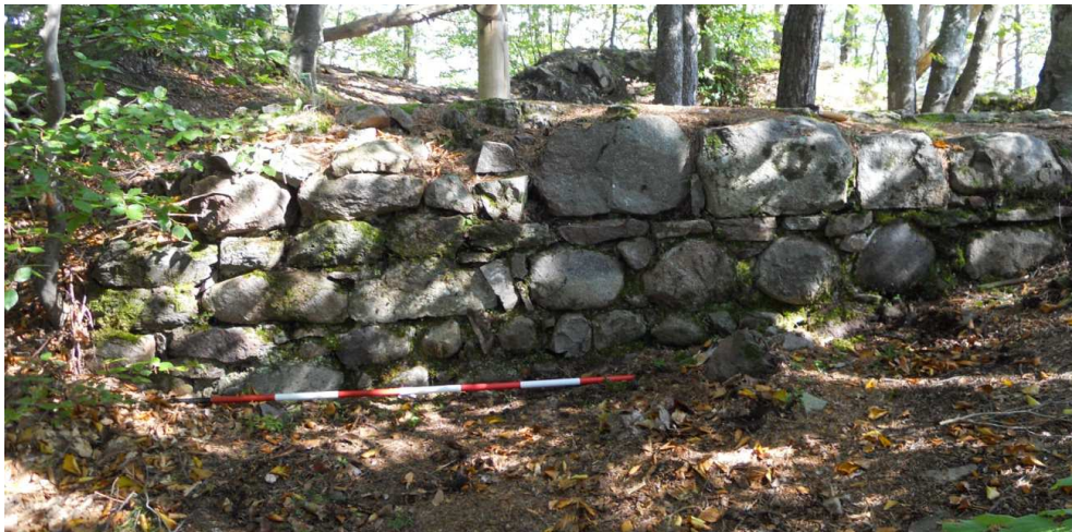
Figura 14. Muro ovest della torre. Il prospetto esterno
