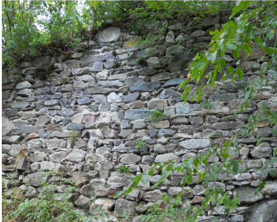
Figura 38. Un tratto di muratura della cinta ovest.
