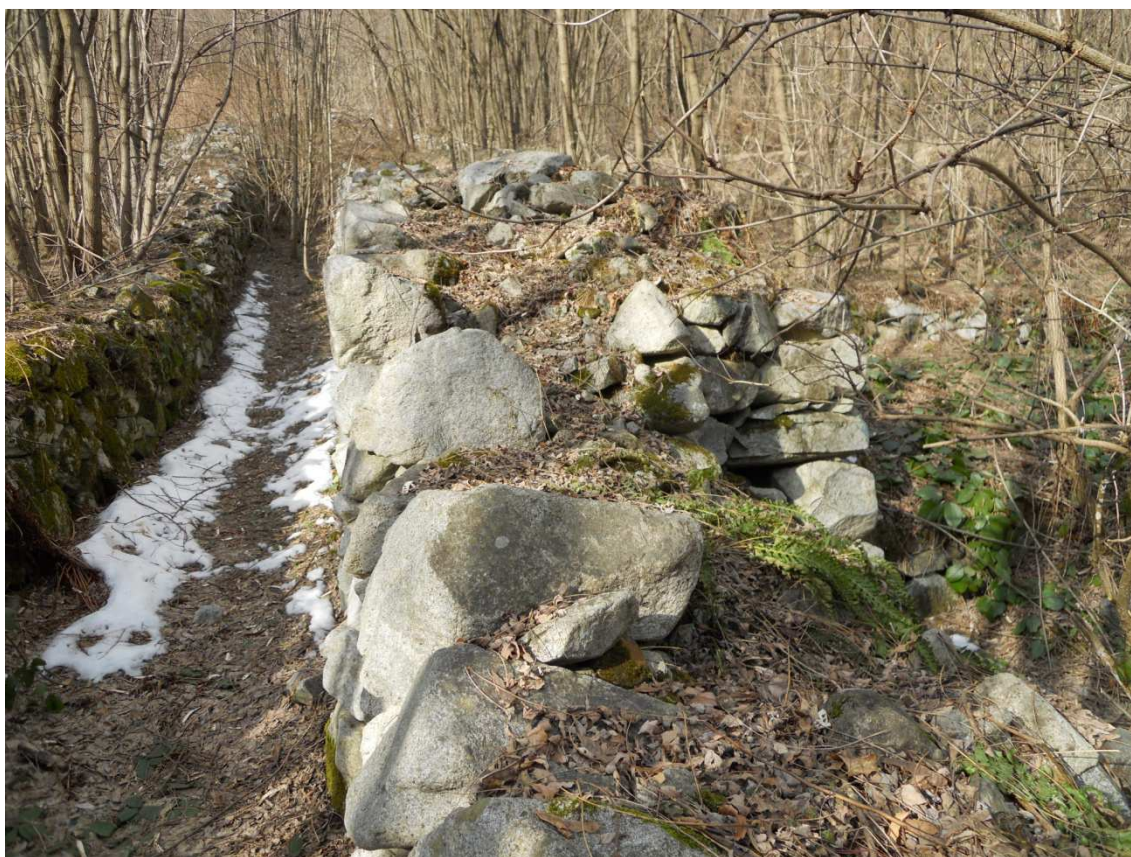
Figura 241. La lineazione ER3 nella zona apicale del conoide. La sede stradale è basolata.
