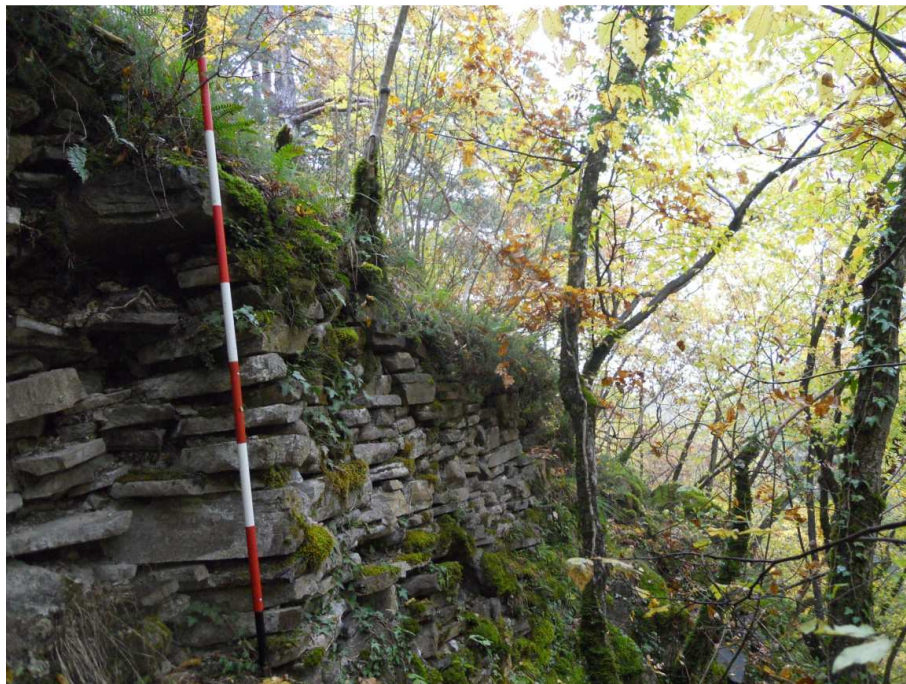
Figura 170. TS 10, Doss Castel. Le strutture della cinta muraria, lato ovest.
