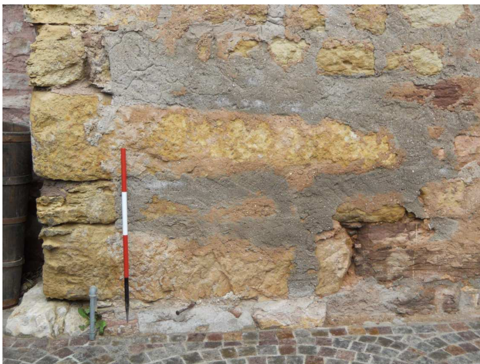
Figura 3. Particolare della tessitura muraria della base della torre.
