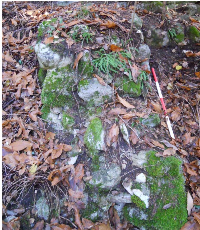
Figura 60. Residuo di un edificio accessorio posizionato a nord rispetto alla torre.
