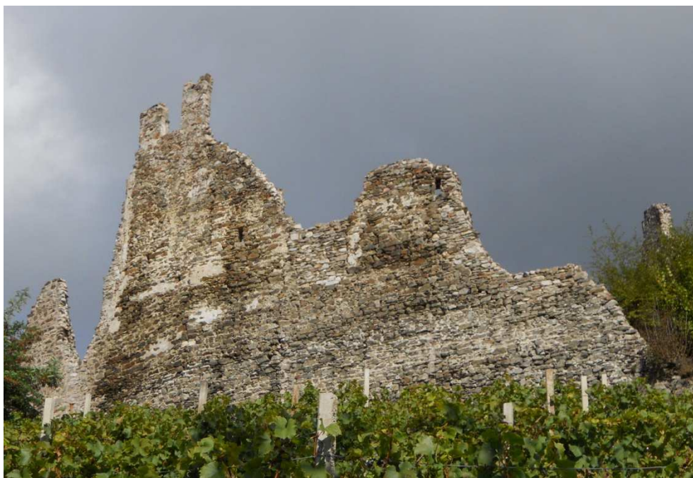
Figura 45. Il prospetto esterno della cinta muraria meridionale.
