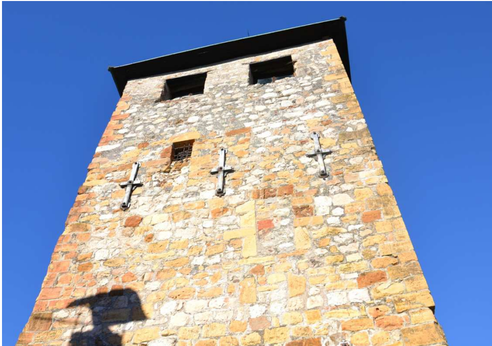
Figura 67. Mastio. Prospetto orientale.
