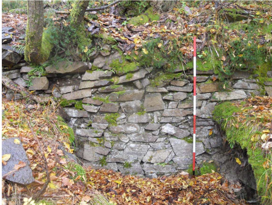
Figura 171. TS 10, Doss Castel. Porzione del muro di cinta, lato est.
