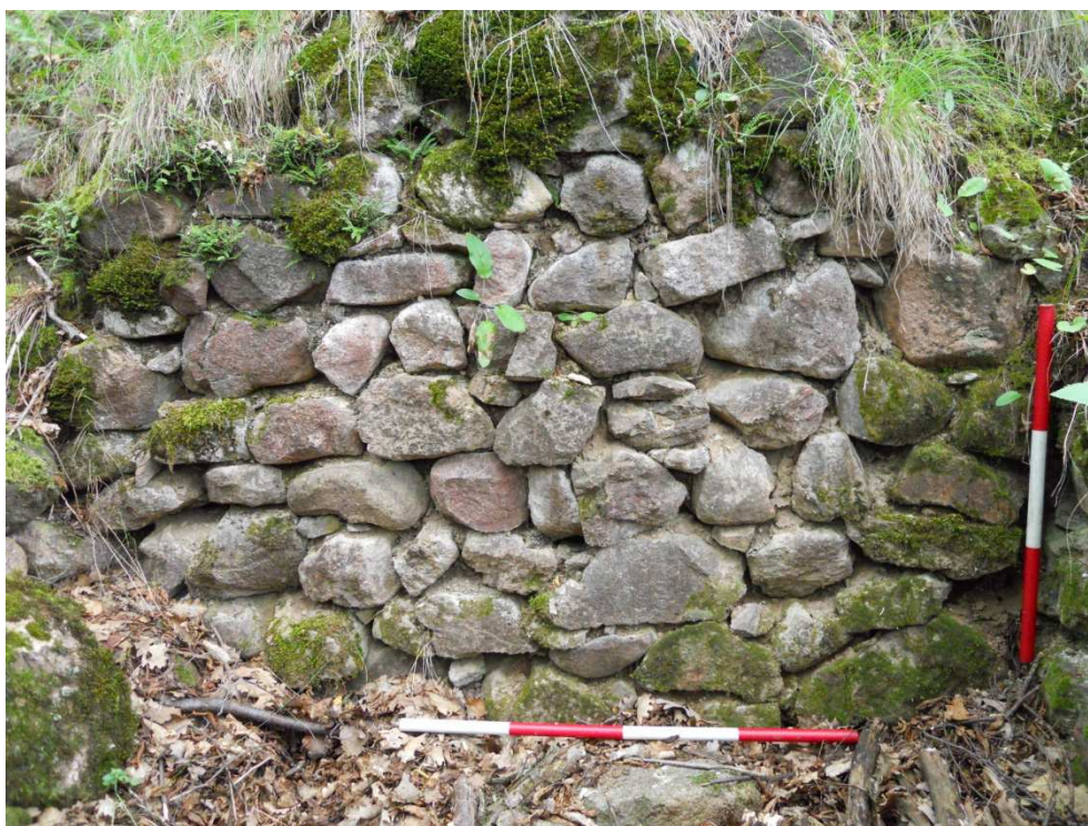
Figura 19. La tessitura muraria del muro est, prospetto interno, del vano accessorio affiancato alla torre.
