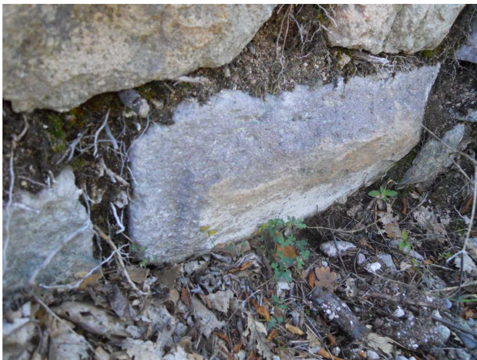
Figura 24. Torre, prospetto interno del perimetrale sud-est. Elemento con lavorazione a bugnatura.
