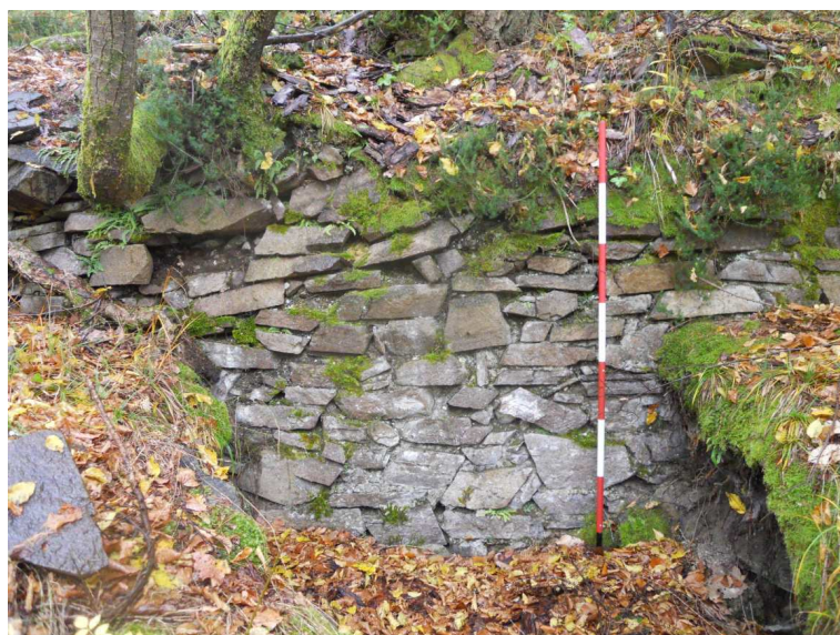
Figura 10. Porzione del muro di cinta, lato est.
