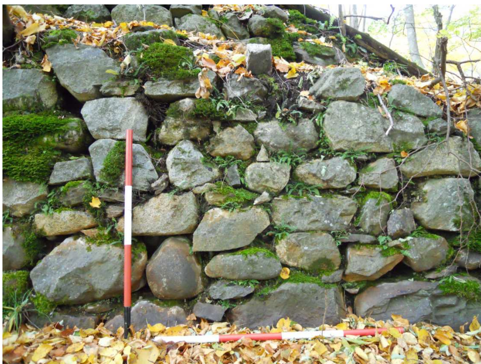
Figura 50. Campione di muratura della struttura che delimita la zona basale della torre.
