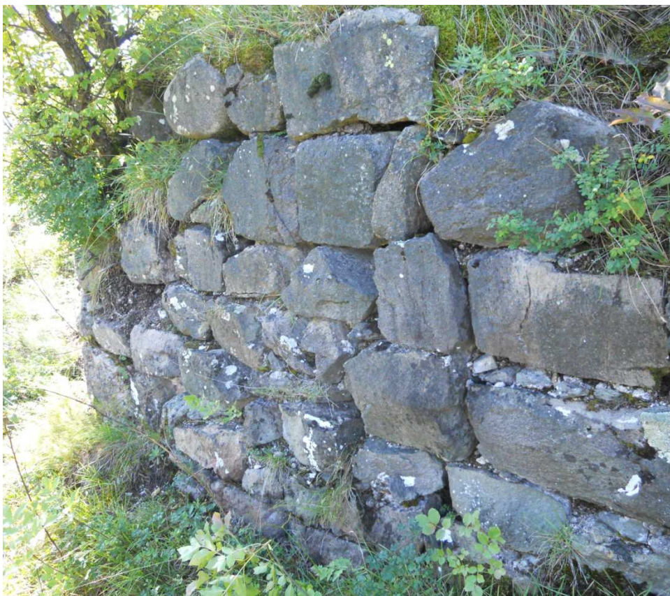
Figura 23. Il prospetto nordoccidentale della torre.
