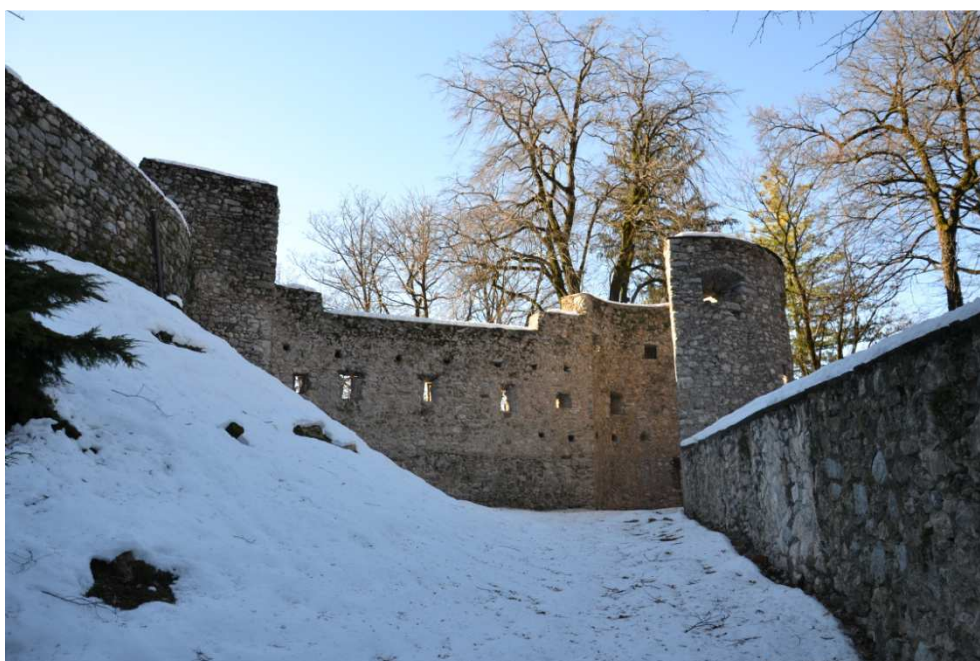
Figura 68. La cinta bastionata di quarta fase
