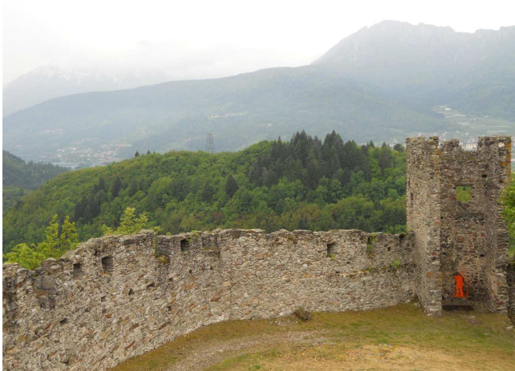
Figura 310. La cinta esterna, con torre scudata, del castello di Pergine.
