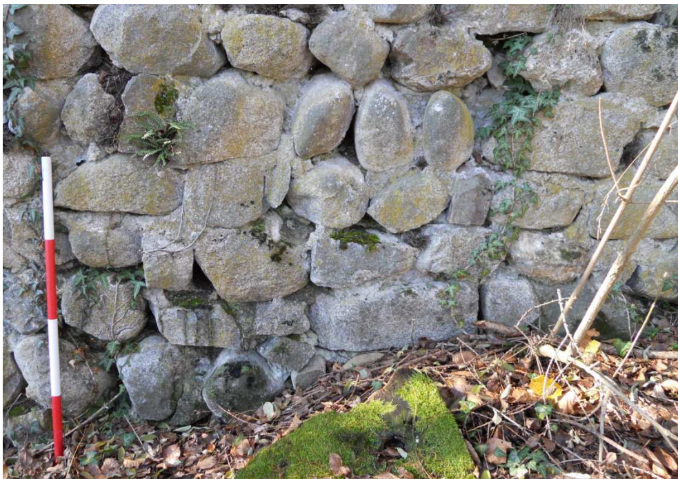
Figura 61. Torre. Particolare della tecnica muraria del prospetto orientale.
