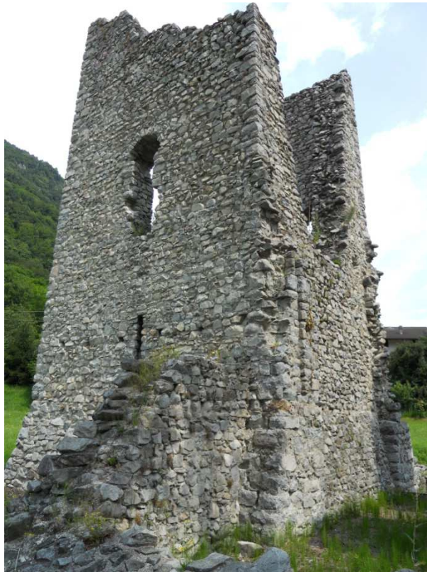
Figura 47. Torre nord. Si nota l'inserzione del sistema di chiusura a ghigliottina.
