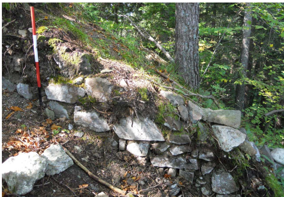
Figura 15. Particolare della struttura esterna alla torre. Prospetto meridionale
