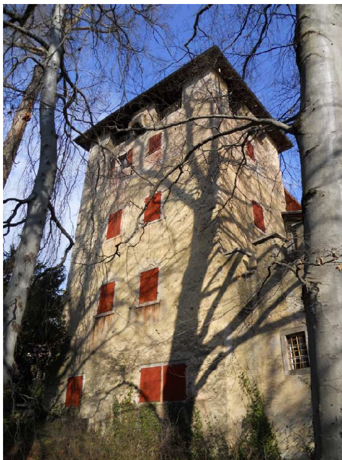
Figura 21. La cosiddetta Torre Grande . Foto da sud-ovest
