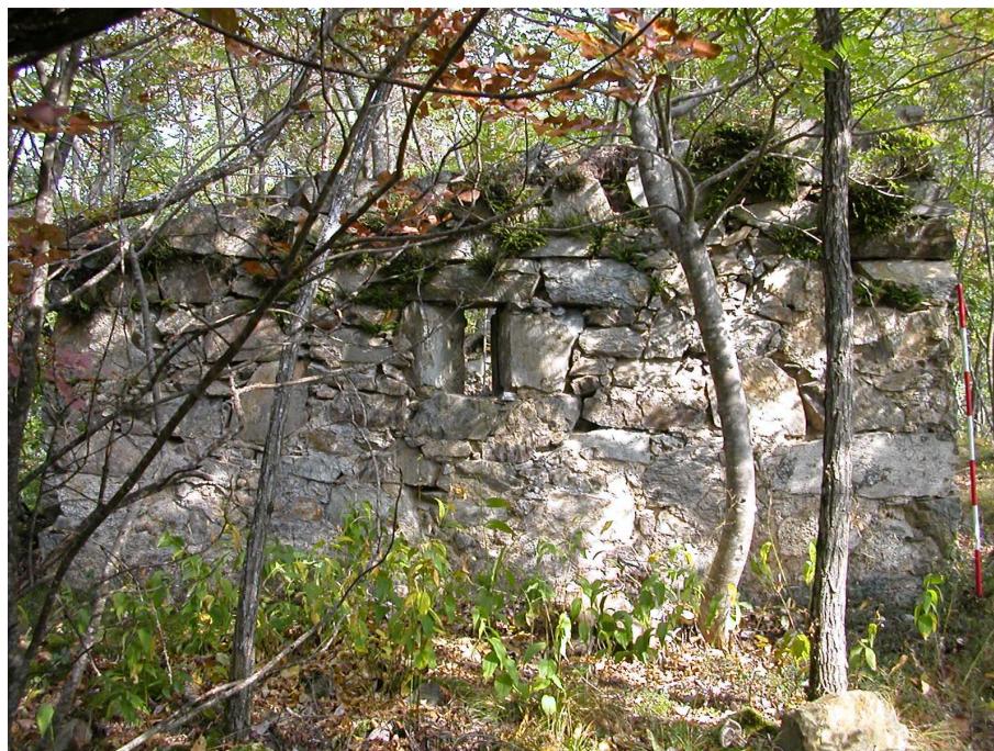
Figura 34. La struttura quadrangolare che occupa la parte sommitale del rilievo.
