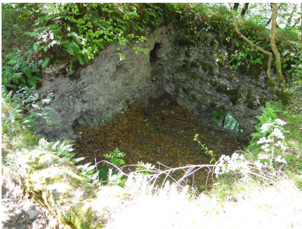
Figura 25. La cisterna. Foto da nord-est.
