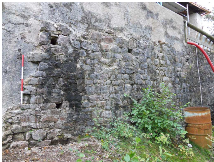
Figura 5. Il tratto superstite della cinta muraria del castello.
