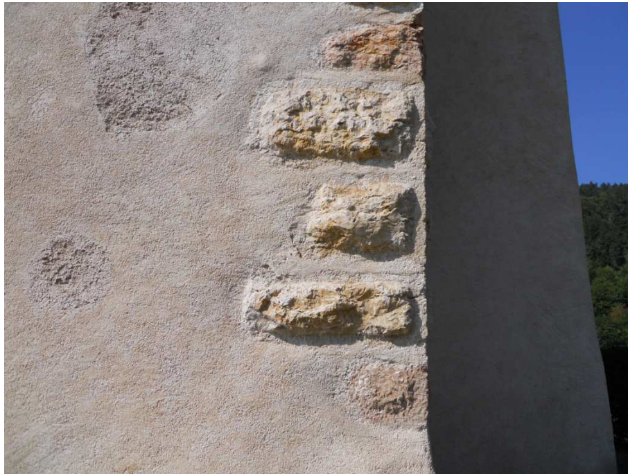
Figura 28. L'angolata di nord-ovest con gli elementi in bugnato
