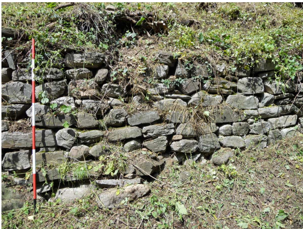
Figura 40. Struttura muraria conservata sul fianco occidentale del rilievo
