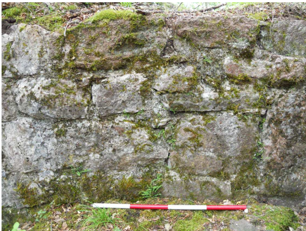
Figura 18. Particolare del prospetto orientale della torre
